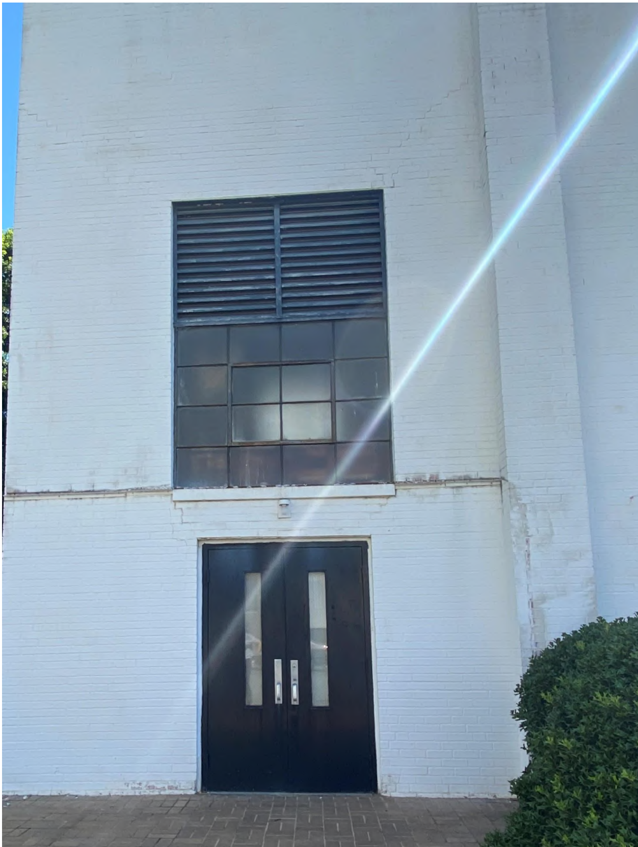
Fig. 12d: Side (West) Elevation Door
